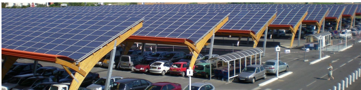
Ombrières, E. Leclerc, Saint Aunes (34)
